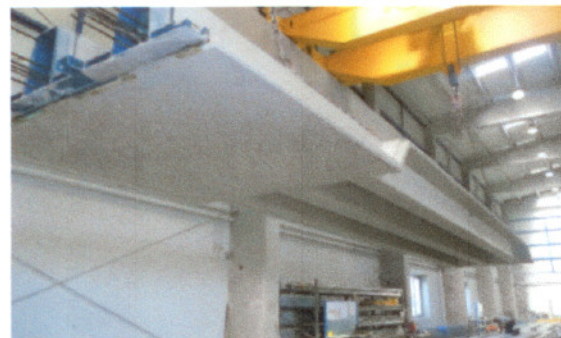
Vorgespannte Rippenplatten für die Lärmschutzgalerie A2 Stansstad.
