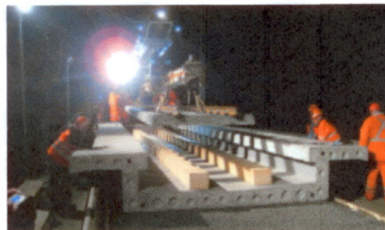
Schottertrögelemente werden zur Sanierung von Viadukten eingesetzt.
