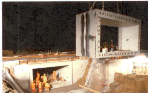
Unterführungselemente SBB, die bisher für rund 150 Bauprojekte produziert wurden.
